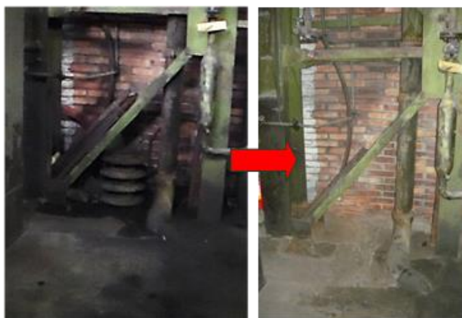
Obr. 1 Príklad rokmi založeného náradia a použitých náhradných dielov
